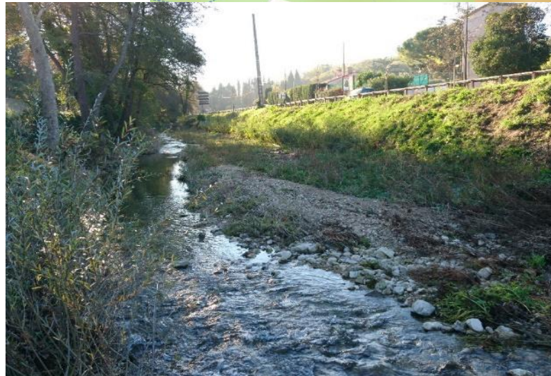
Etat post travaux
